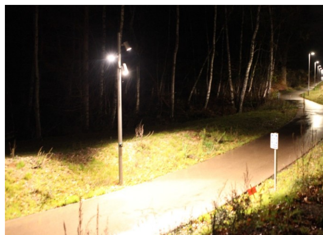
Eksempel på eksisterende sti belysning,
